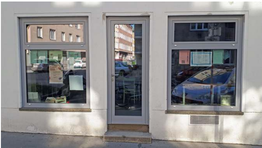
Foto 10: Fassade eines Quartiersnetzwerks (2019)
