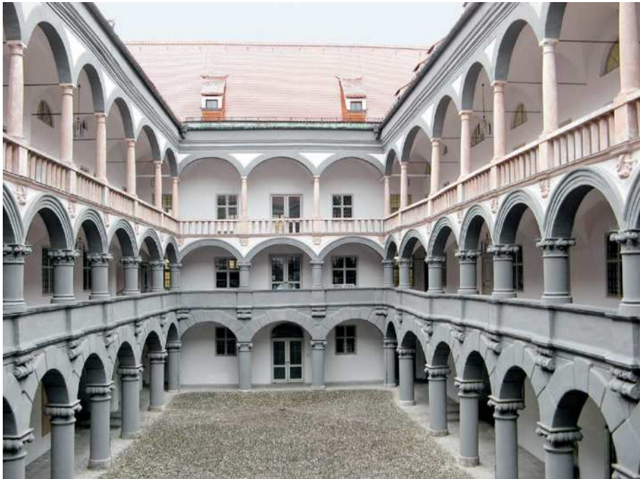
Abb. 8: Innenhof des Marstallgebäudes, das Herzog Albrecht V. 1563–1567 nahe dem Alten Hof erbauen ließ. Foto: Gudrun Szczepanek
