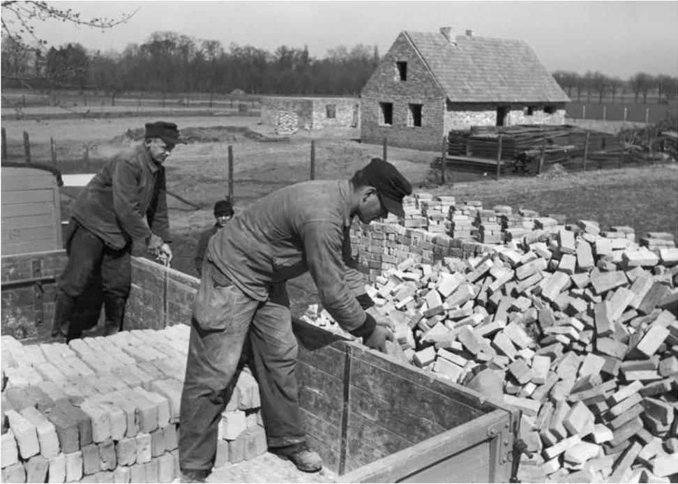
**Abb. 2: Abbruch-Ziegelsteine werden zur Errichtung von Neubauernhöfen im Kreis Teltow verwendet, April 1948.**
