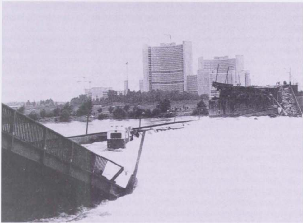
Abb. 139: Einsturz der Reichsbrücke.
