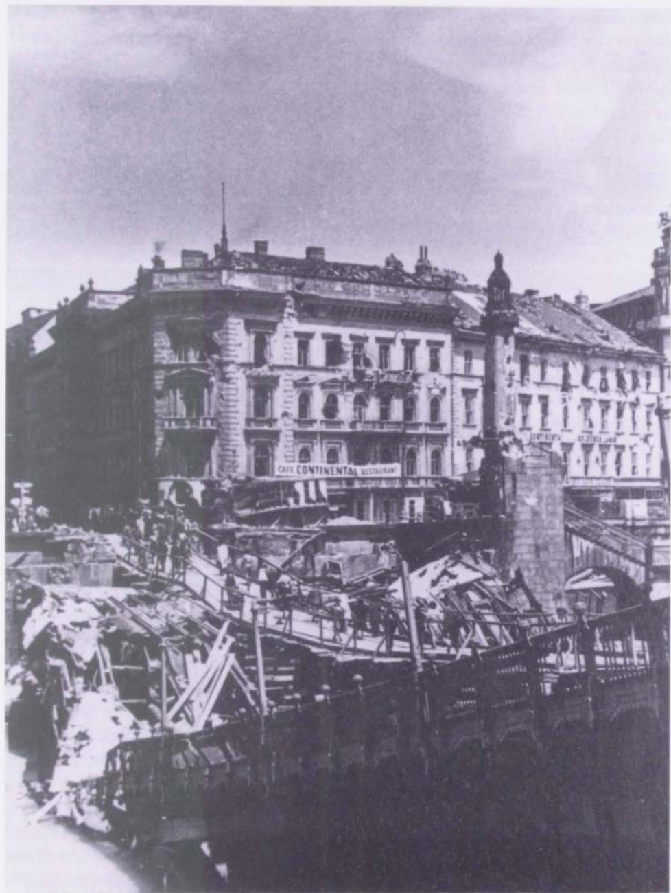
Abb. 125: Die gesprengte Schwedenbrücke.
