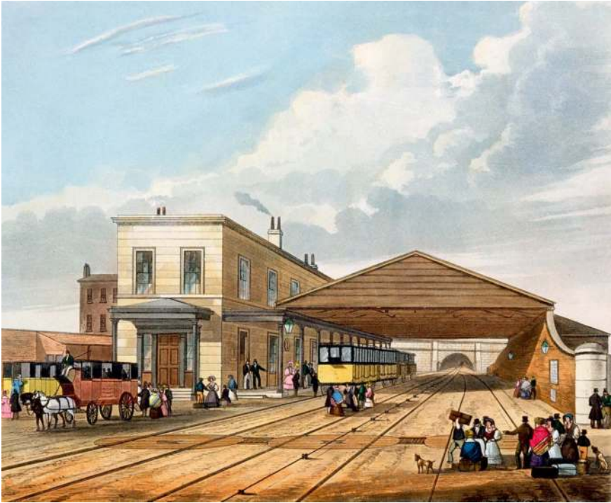
Abbildung 11: Ansicht des Bahnhofs Liverpool mit Empfangsgebäude und überdachter Wagenhalle.
