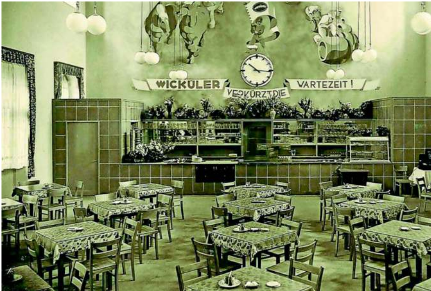
Abbildung 23: Innenansicht des Wartesaals 3. Klasse im Hauptbahnhof Wuppertal (ehemals Elberfeld), um 1960.
