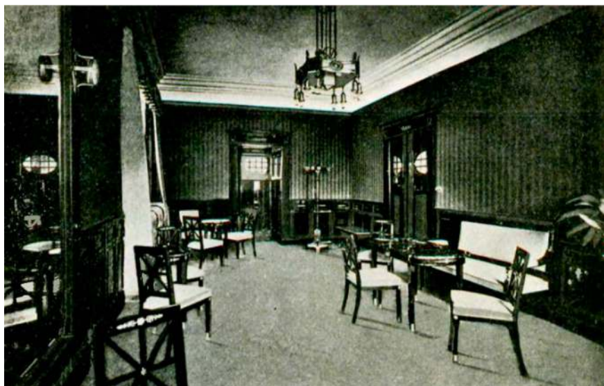
Abbildung 33: Damensalon im Hauptbahnhof Wiesbaden.
